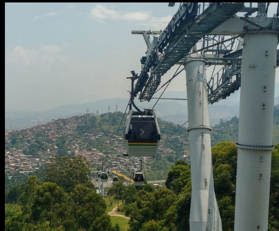
9. Linha J do Metrocable a partir da Estação La Aurora. A Linha J possui quatro estações e está interligada à Linha B do Metrô, na Zona Oeste da cidade.
