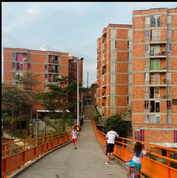
6. Ponte El Mirador e Intervenção Urbana La Herrera, Comuna 2. ocable.
