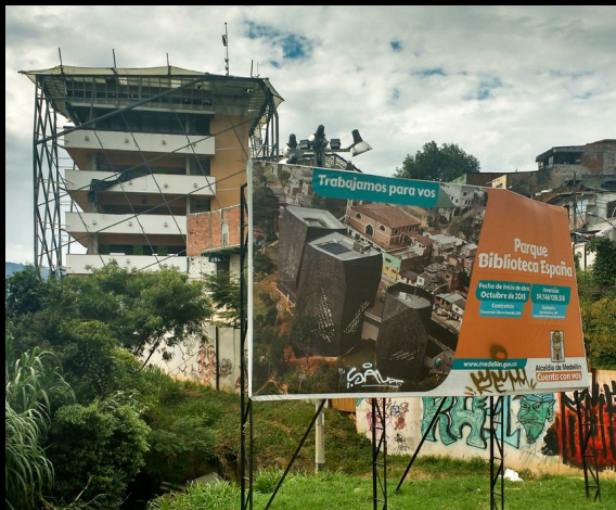
8. Parque Biblioteca España, a mais icônica obra arquitetônica das intervenções recentes em Medellín. Desde 2015, a biblioteca está fechada por apresentar problemas estruturais e de impermeabilização, por isso foi parcialmente desmontada. Em 2020, antes do início da pandemia de COVID-19 na Colômbia, a Prefeitura de Medellín divulgou um Plano de Recuperação da biblioteca, prevendo, respectivamente, licitações, obras e reinauguração do equipamento para 2020, 2021 e 2022.
