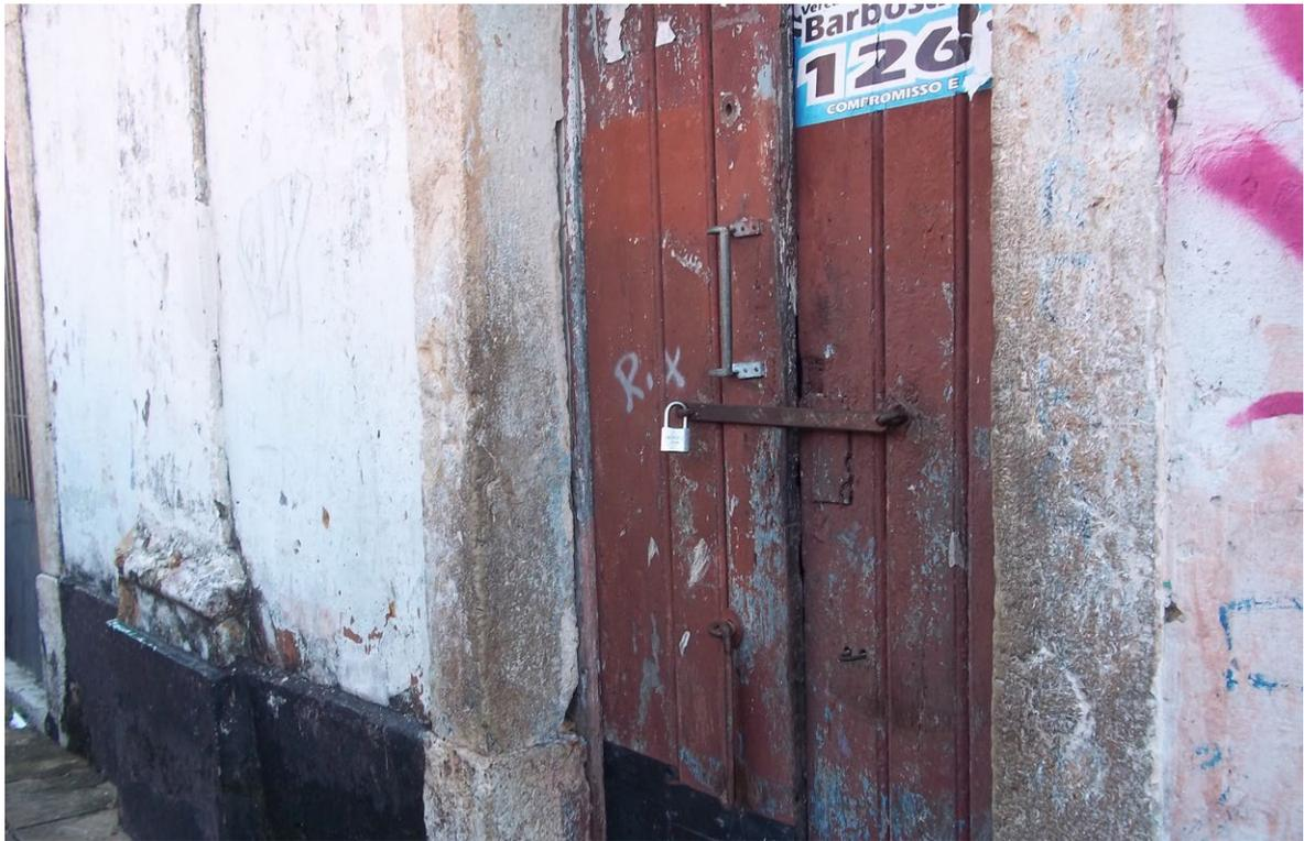
estado de deterioração das madeiras desgastadas pela ação do tempo.
