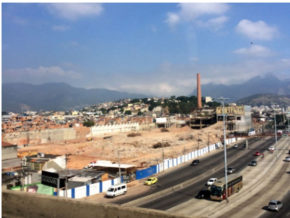
Figuras 1 e 2: Antiga Fábrica de Sabão Português em processo de demolição e o hipermercado que foi construído em seu lugar
